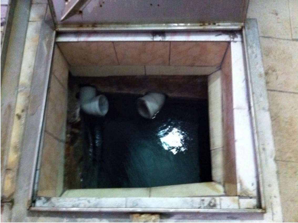
Şekil 4.2 İnegöl-Oylat kaplıcası kaynağı.
