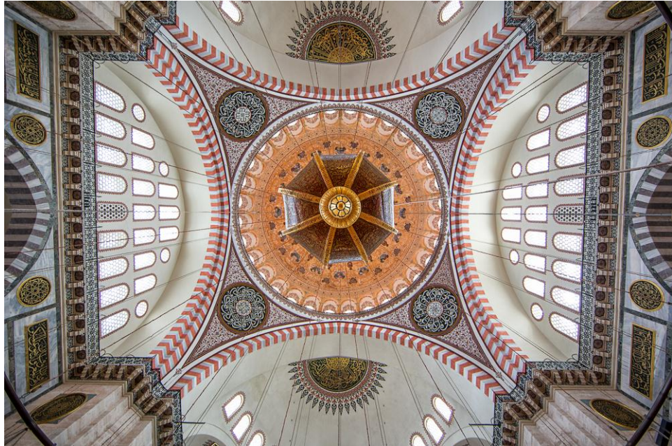
Fotoğraf 4.2.20 Dört Fil Ayağı Üzerinde Büyük Kubbe
